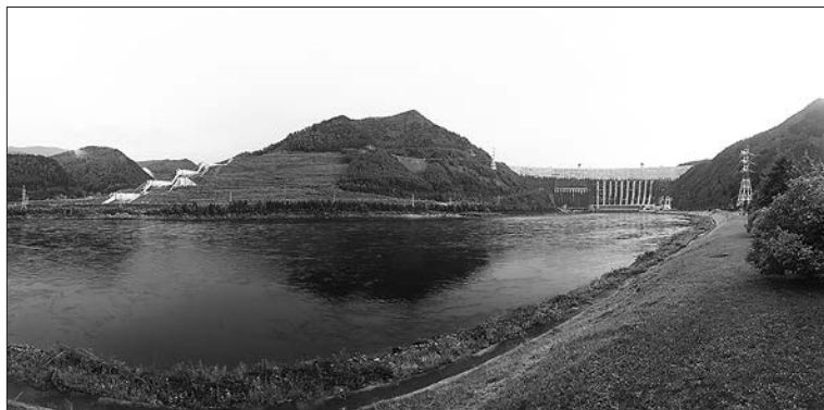
Плотина и береговой водосброс
